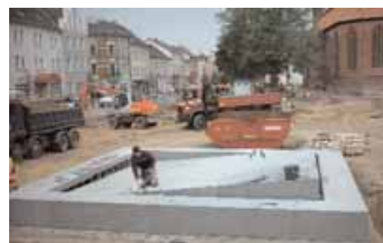
Montage der Brunnenanlage im Stadtzentrum
