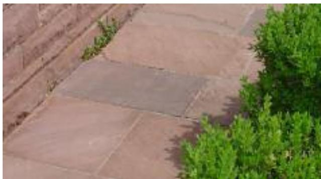
**4 Nach dem Abspülen** sieht die getrocknete Fläche aus wie neu. Unkraut in den Fugen abflammen oder mechanisch entfernen
