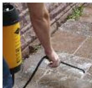
**2 Zur Beseitigung** wird der alkalische Grundreiniger (zum Beispiel von Lithofin) auf die komplette Fläche gesprüht
