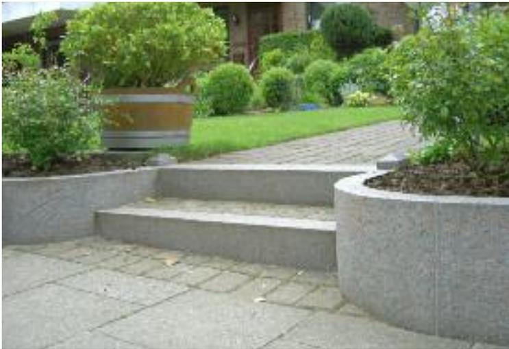
**Fachmännisch verlegt** Ein solider Unterbau mit guter Drainage erleichtert das Reinigen von Natursteinflächen (Rechtglaub-Wolf)
